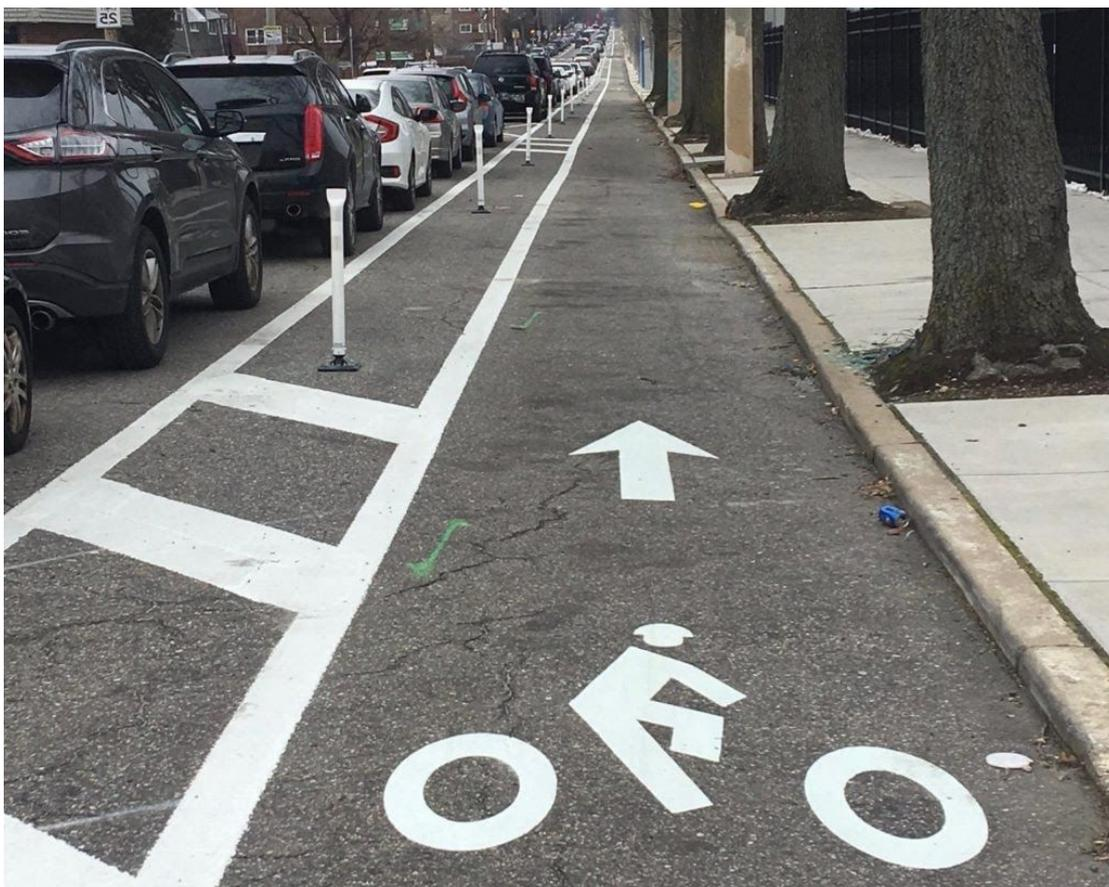
Bild 2: Schräg markierte Pufferzone mit baulichen Elementen zwischen Parkplätzen und Radweg (Foto: [Bicycle Coalition of Greater Philadelphia](#))
