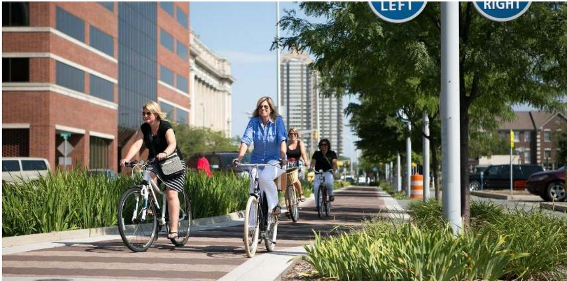
Bild 1: Breiter Radweg mit Bepflanzung als Sicherheitstrennstreifen (Foto: [Green Lane Project](#))
